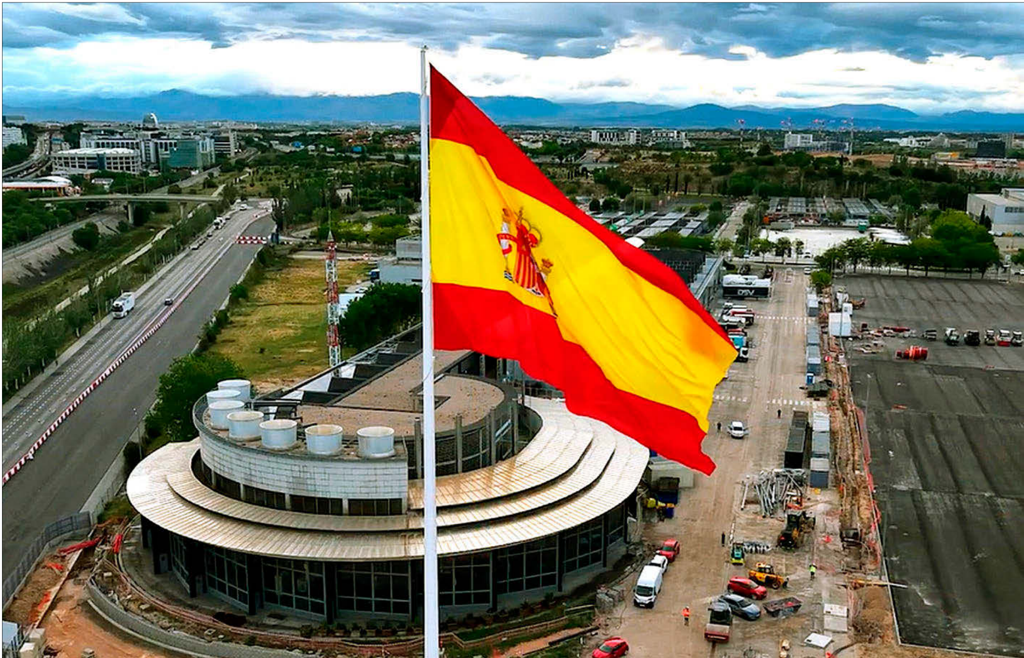
La gran bandera de España de Madring, que preside las primeras curvas del circuito, a vista de dron tras ser instalada e izada. IBERTI
